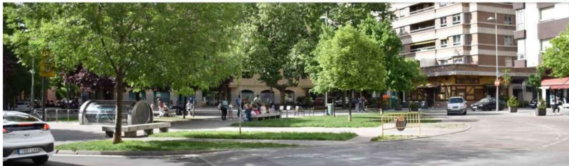
Plaza de San Miguel 2009. Recuperación de espacio y elevación de la calzada a la altura de la acera
